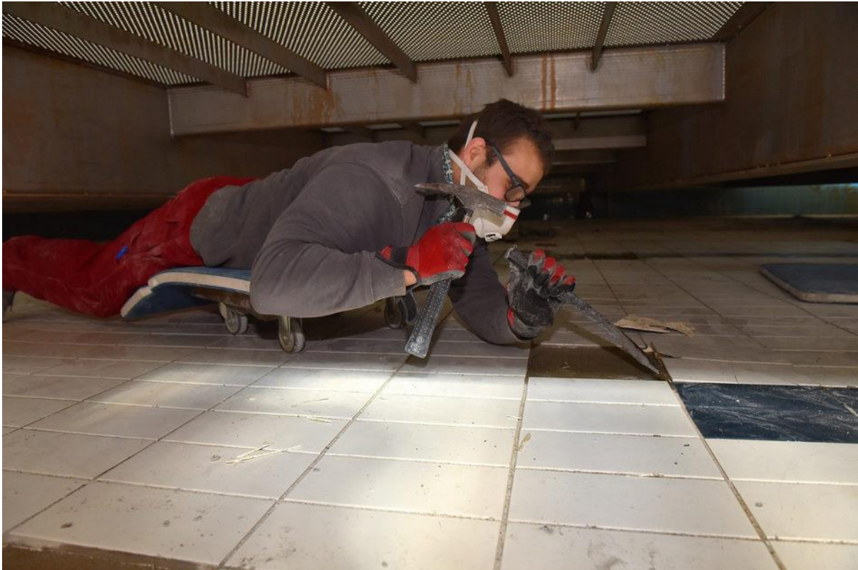
Saunameister Wilhelm Rudolph hat die Tätigkeit gewechselt und reißt lockere Fliesen aus dem Schwimmbecken. © Egbert Kamprath
